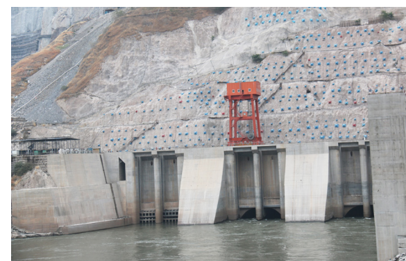
尾水出口边坡工程形象
