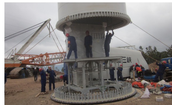
姚安小箐山46MW风电场项目 塔筒吊装
