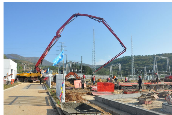
监理旁站主变基础浇筑
