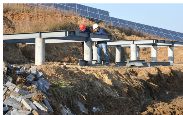
监理检查箱变基础钢构
