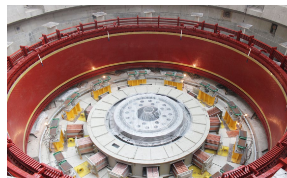
2号机定子下线及耐压完成
