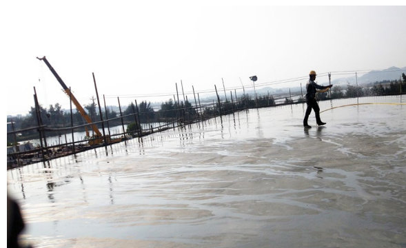
浇筑完成的板面混凝土养护
