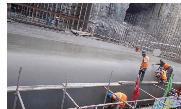
泄洪洞进水塔底板圆弧段浇筑效果
