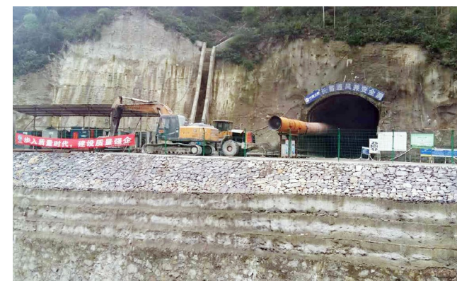
导流泄放洞出口洞脸边坡开挖形象
