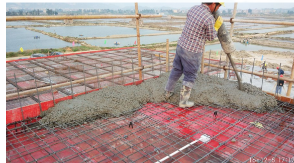
电控楼屋面混凝土浇筑
