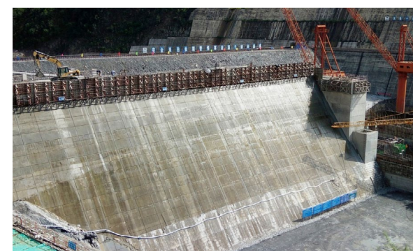
混凝土面淋水养护形象
