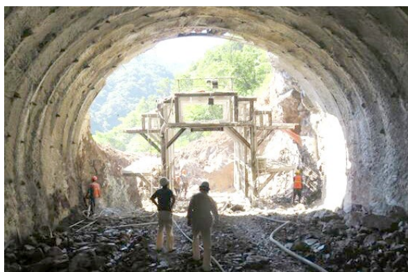
勘探道路2#隧道贯通时施工形象
