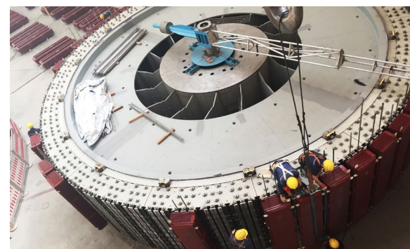
2号机转子磁极挂装
